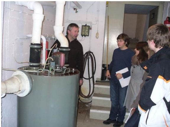
Abb. 3.8 Hebeanlage, Internatsgebäude
